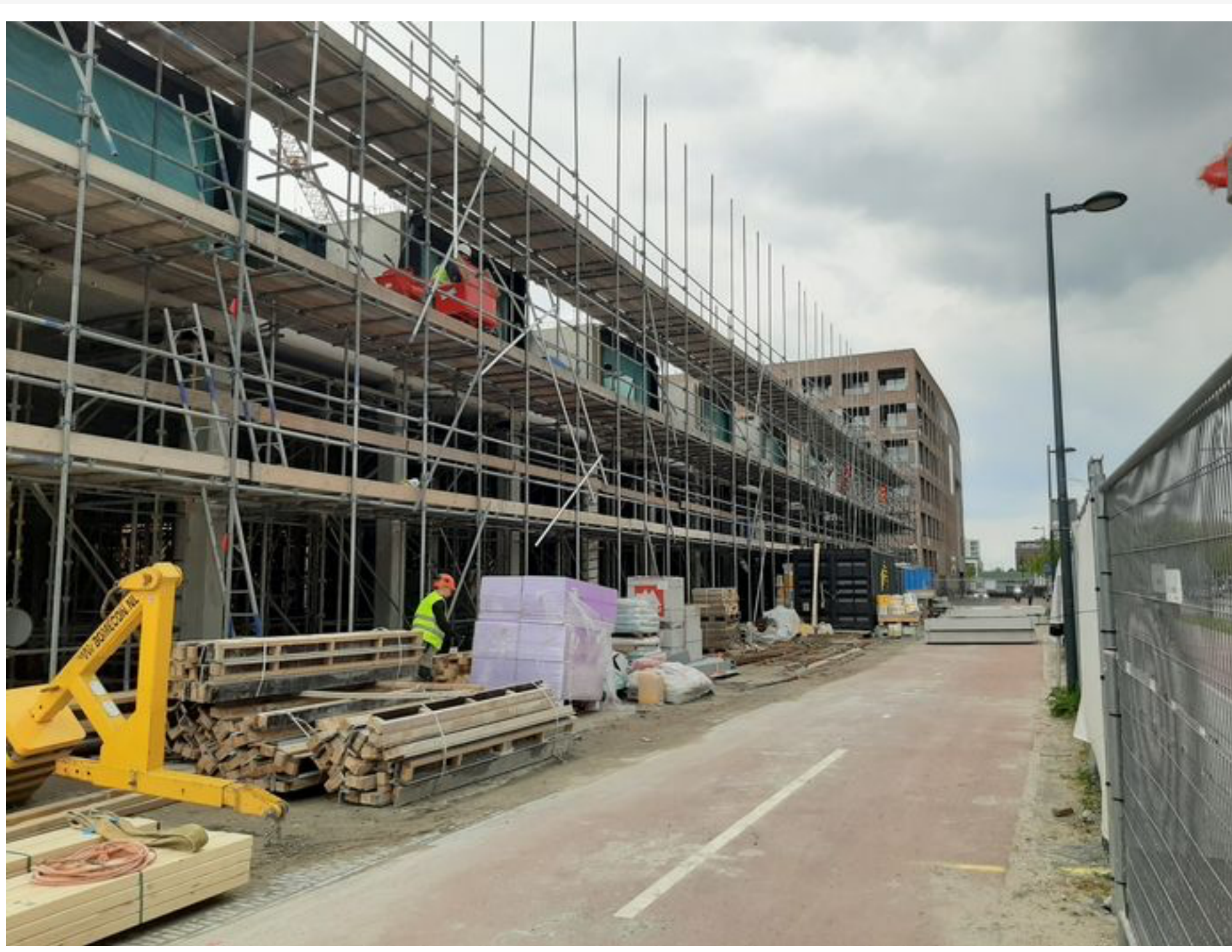
▲ Er wordt flink gebouwd in Breda, zoals naast het station, waar op de hoek Stationslaan, Terheijdenstraat de Belcrumpoort verrijst © Edine Wijnands
